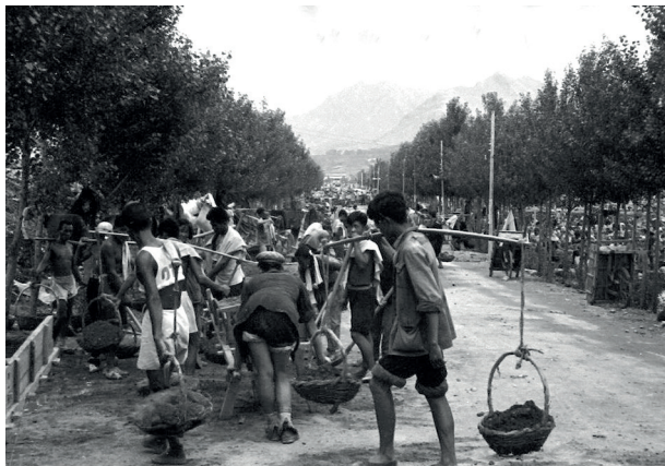
Straßenbau zur Baustelle
