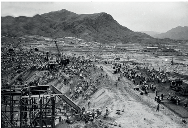
Überblick über die Baustelle
