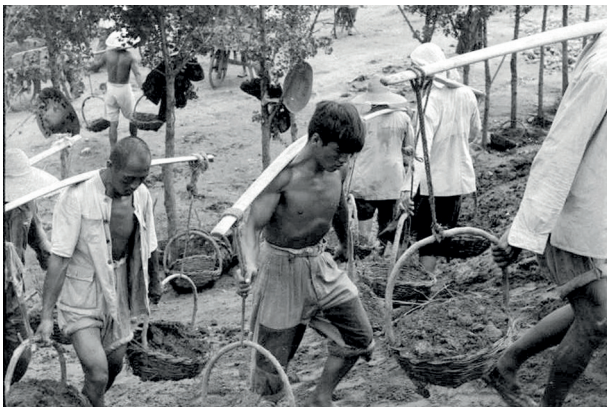
Korbräger transportieren Erde
