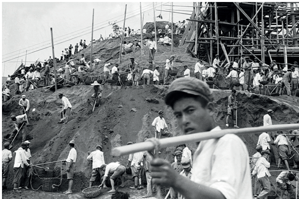
Staudammbau bei den Ming-Gräbern
